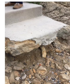
Les escaliers des Anthénors font l'objet d'un affouillement au niveau de la plage (extrémité Est)
