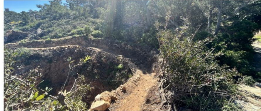
Elargissement de la plateforme du sentier: Reculé de la plateforme avec création d'un soutènement en pierres sèches et dépose et replantation des pittos existants
