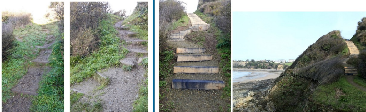
Les escaliers des Anthénors font l'objet d'un affouillement au niveau de la plage (extrémité Est)
