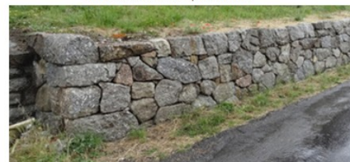
Mur de soutènement en pierres sèches
